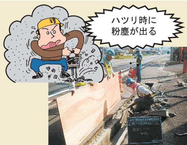
従来工法であるコンクリートブレーカーによるハツリ作業
