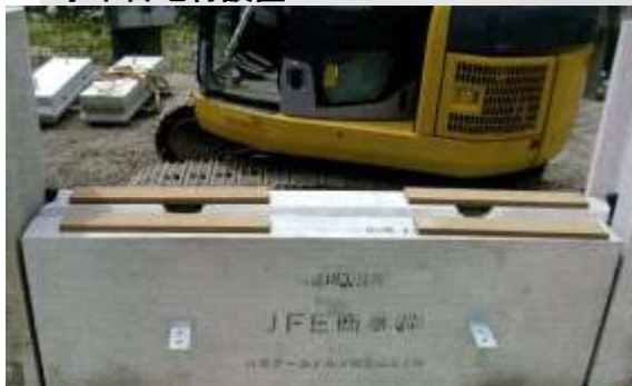
水平目地材設置
