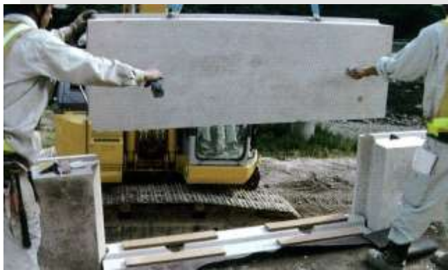
壁面パネル組立て・設置
