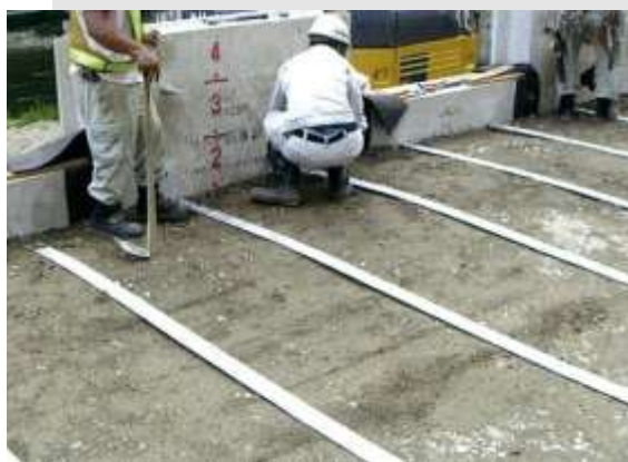
補強材（ストリップ）敷設
