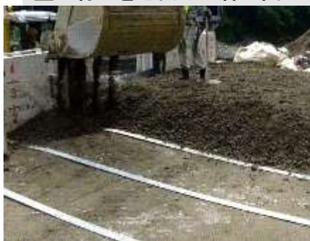
盛土材の巻き出し・締め固め
