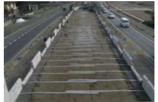
工事中の津ノ井バイパス宮長改良工事現場
