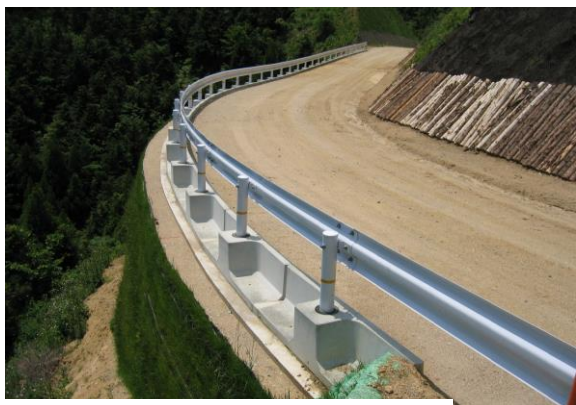
鳥取県発注 西伯町 行者山林道現場
