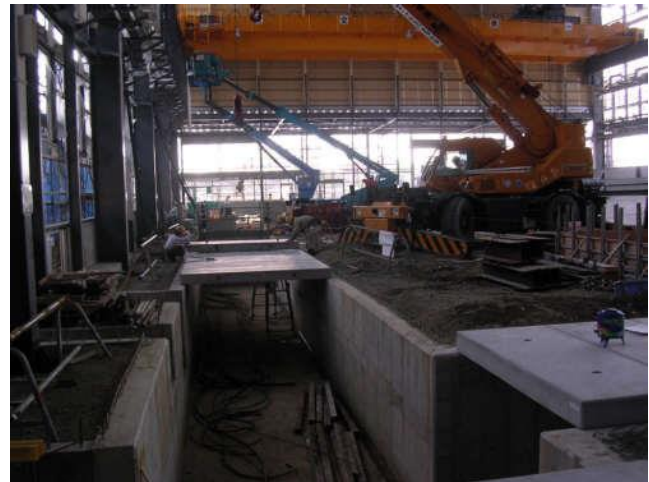
(4) 他の作業を止めることなく、5 時間程度でスラブ施工完了
