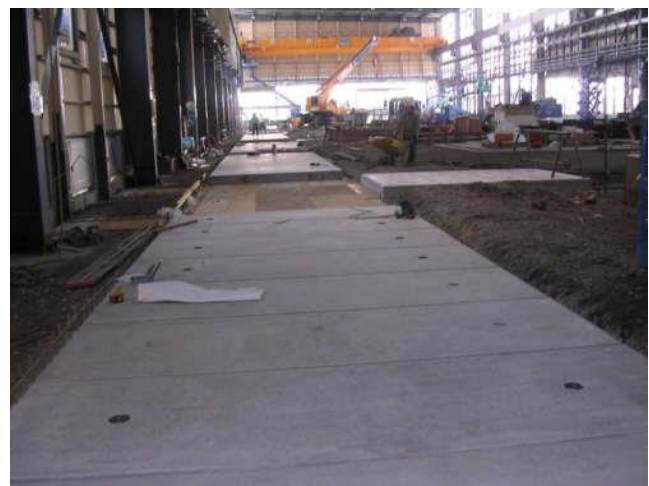
(4) 他の作業を止めることなく、5 時間程度でスラブ施工完了
