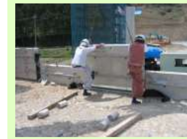
コンクリートパネル組み込み
