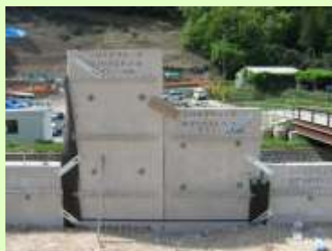
コンパネとの連結状況
