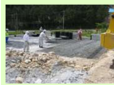
スパイクグリッド敷設状況
