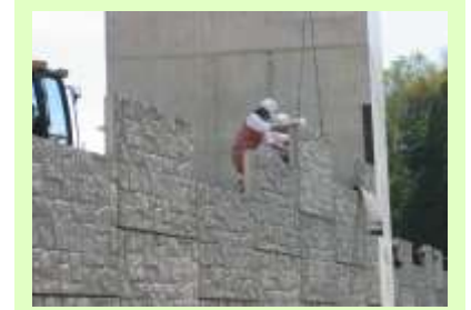
コンクリートパネル組み込み
