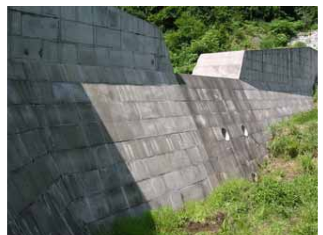
八頭町姫路現場 砂防堰堤 表面【化粧アリ】 裏面【化粧ナシ】
