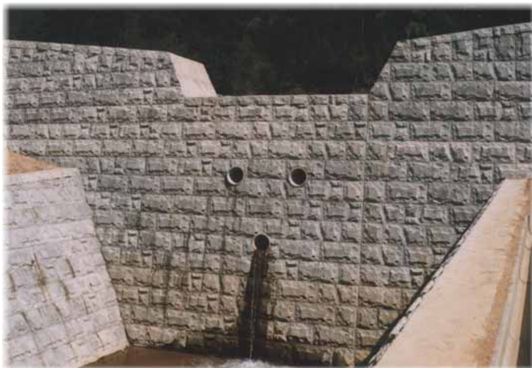
八頭町姫路現場 砂防堰堤 表面【化粧アリ】 裏面【化粧ナシ】
