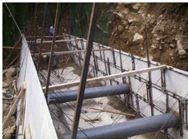
施工中の様子
