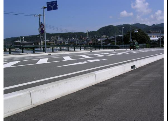
境界ブロックの下には側溝が埋まっています
