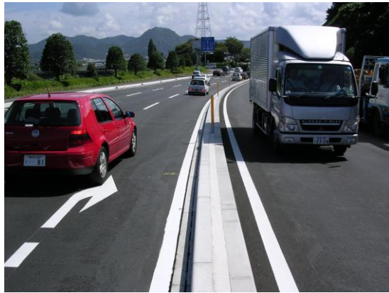
中央分離帯として使用
