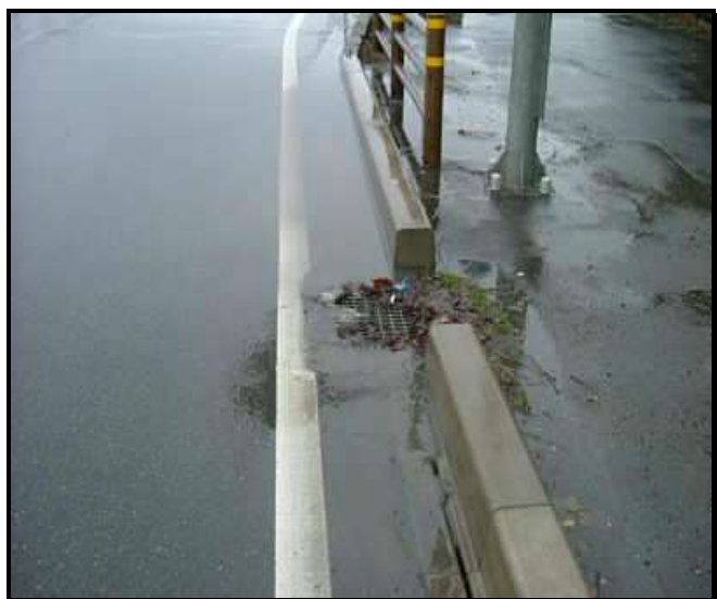
手前の縁石部分(両面スリット付)がかんたん側溝、奥側が他社の製品です。水たまりの違いがはっきりしています
