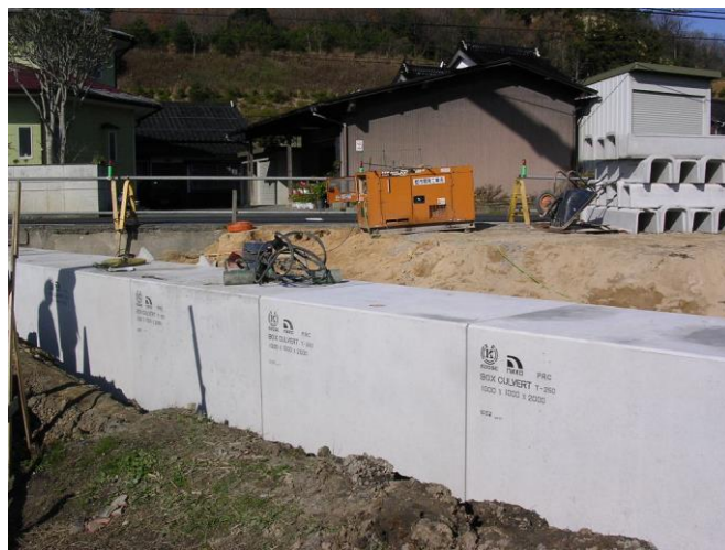
施 工 中 の 様 子
