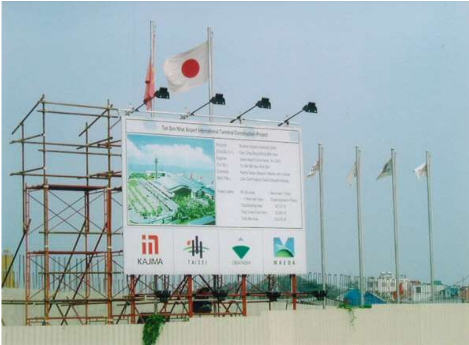
ホーチミン空港 新築工事(日本からの ODA)
