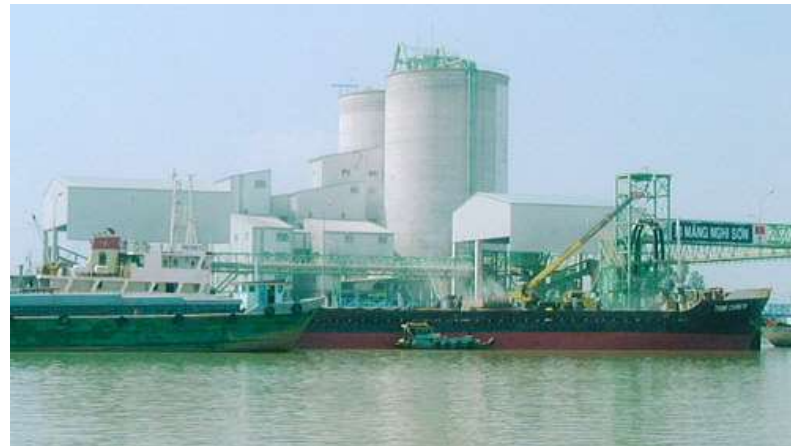
ホーチミン・サービスステーション全景
