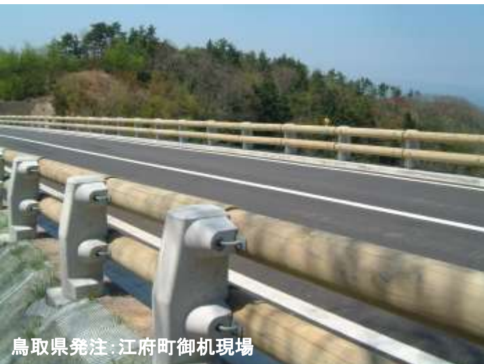
コンクリートの支柱に木製ガードレールを取付
