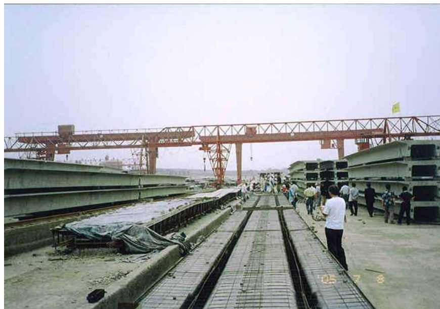
写真 4 建築用スラブ専用工場
