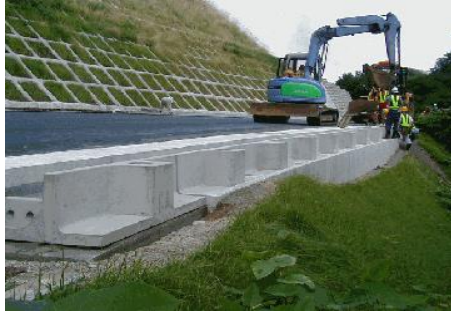
L型擁壁の背面に沿って設置 (青森県:県道)
