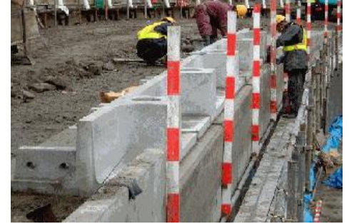
テールアルメ盛土壁上への設置 (新潟県:県道)
