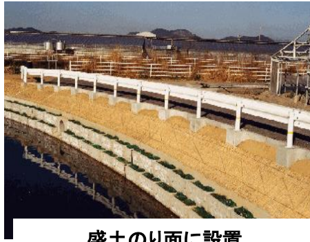
盛土のり面に設置 (高知県:県道)
