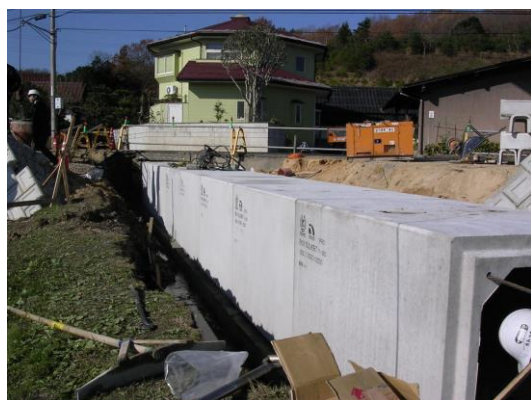
参考写真 (鳥取市内ボックスカルバート現場)
