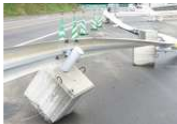
仮設防護柵に車が衝突した現場
